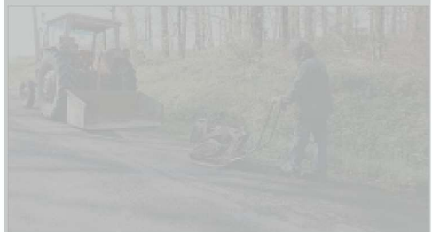
TRAVAUX. Didier Chatard, agent communal, nivelle le bitume.
