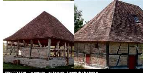
PROGRESSION. Reconstruire une bergerie, à partir des fondations.
