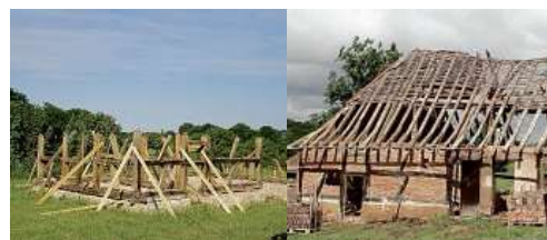
AVANT-APRÈS. Cette maison à trons couchés de Thionne était en très mauvais état. Il a fallu la mettre à nu pour la reconstruire, avec des matériaux et techniques anciennes. PHOTOS DR
